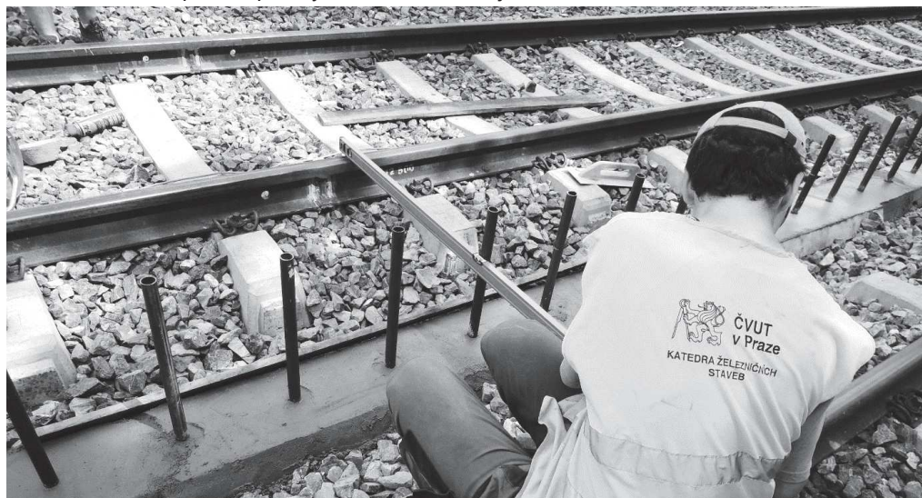
Obr. 2. Kontrola správné polohy základu vůči koleji
