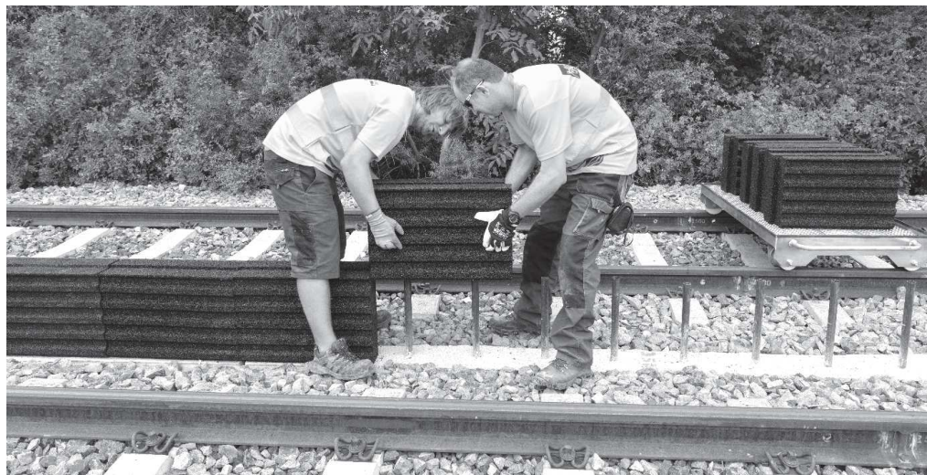
Obr. 3. Umísťování segmentů 2. generace MPHČ na dokončený základový pás
