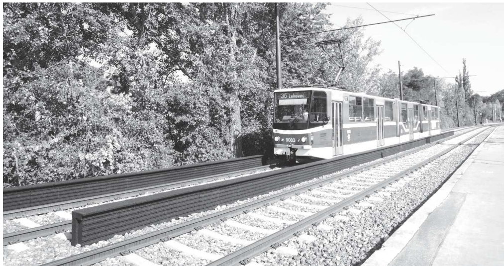
Obr. 5. Celkový pohled na protihlukovou clonu v běžném provozu
